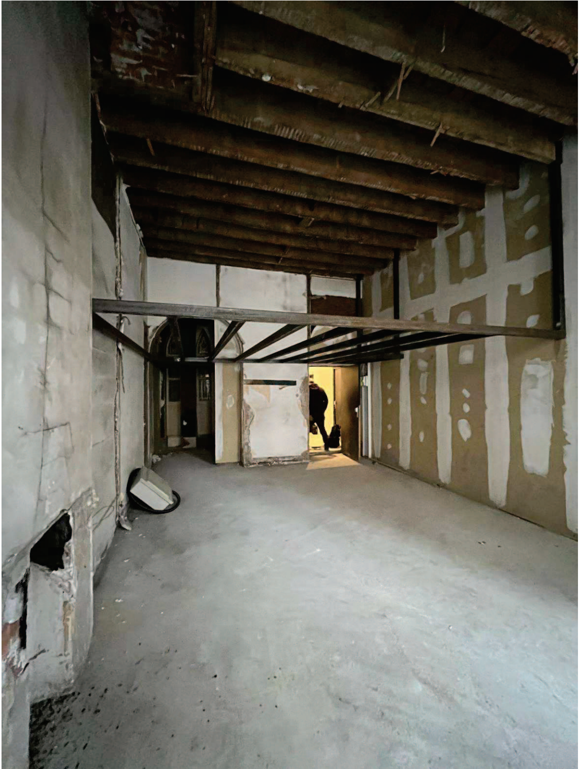
Le sol est revêtu d'une chape de ciment brut.
