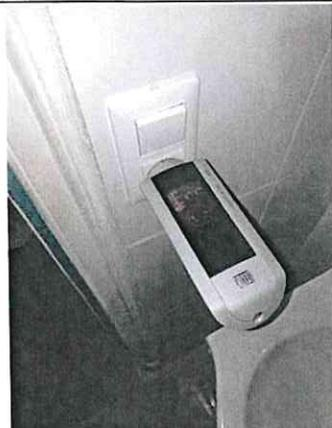
Photo socle de prise de terre non raccordé à la terre
