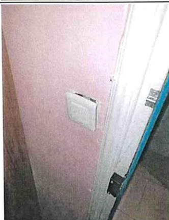
Photo enveloppe socle d'interrupteur dégradé
