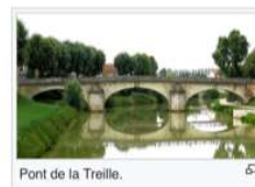
Pont de la Treille.
