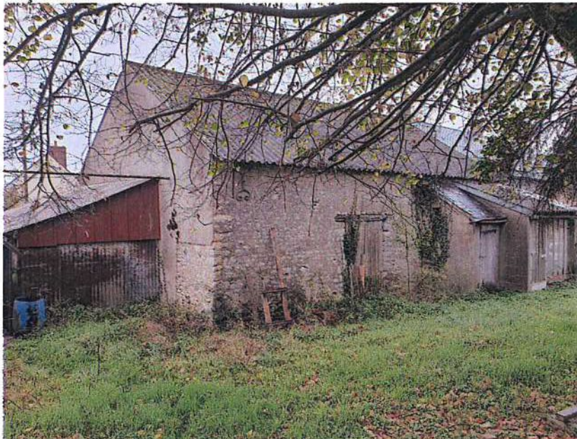
Façade arrière et pignon droit
