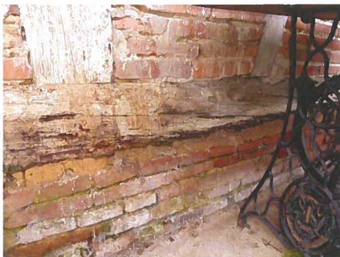
Une poutre horizontale est vermoulue.
