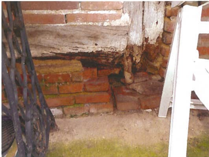
Une poutre horizontale est vermoulue.
