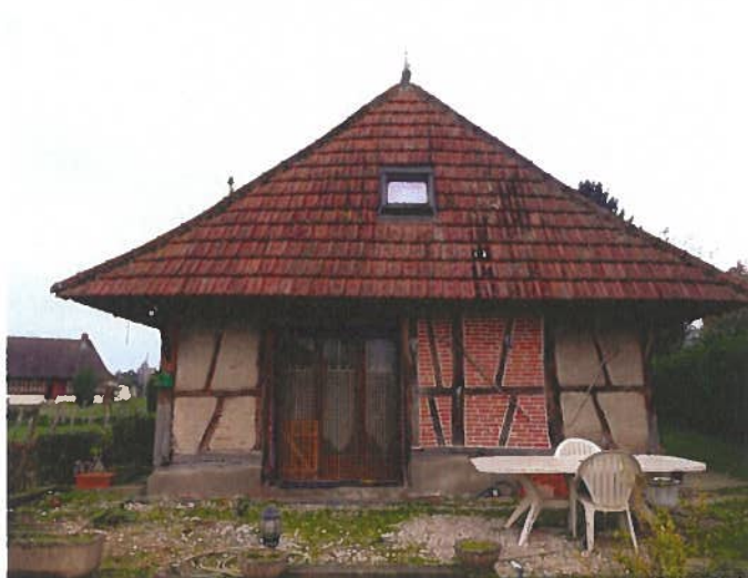
La façade Est est ancienne, en briques et colombages, et briques partiellement crépies. Il y a un robinet d'eau.
