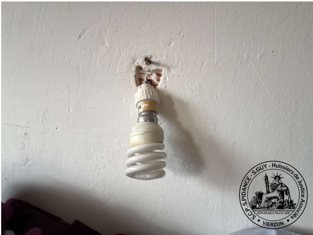
Éclairage mural muni d'une douille avec ampoule, branchement à revoir.
