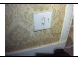
Photo PhEle004 Libellé de l'information complémentaire : B11 b2 Au moins un socle de prise de courant n'est pas de type à obturateur
