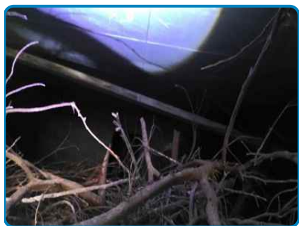
Plafond Hourdis polystyrène (dans Villa Clos & Couvert Vide sanitaire)
