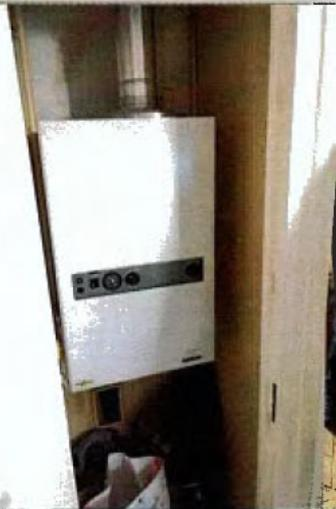
*Description :* La CONNEXION à la LIAISON EQUIPOTENTIELLE principale d'au moins une CANALISATION métallique de gaz, d'eau, de chauffage central de conditionnement d'air, ou d'un élément CONDUCTEUR de la structure porteuse du bâtiment n'est pas assurée (résistance de continuité > 2 ohms).
