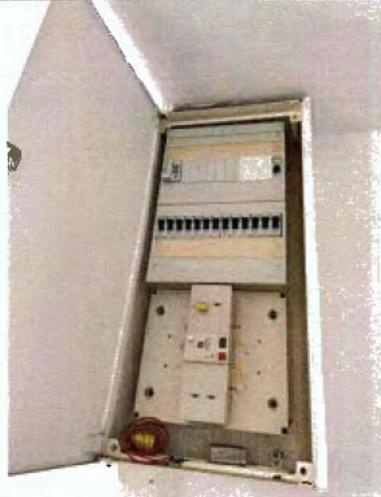
*Description :* Le dispositif assurant la COUPE D'URGENCE est placé à plus de 1,80 m du sol fini et n'est pas accessible au moyen de marches ou d'une estrade.
