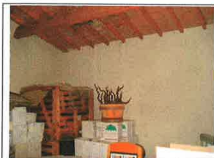
Photo n° PhA001 Localisation : Cuvage 2 Ouvrage : Murs, Cloisons "en dur" et Poteaux (périphériques et intérieurs) Partie d'ouvrage : Enduits projetés Description : Crépi gratté blanc - Mur Localisation sur croquis : P1
