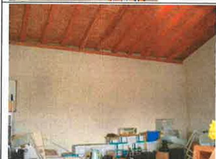
Photo n° PhA001 bis Localisation : Cuvage 3 Ouvrage : Murs, Cloisons "en dur" et Poteaux (périphériques et intérieurs) Partie d'ouvrage : Enduits projetés Description : Enduit gratté blanc - Mur Localisation sur croquis : P1 bis
