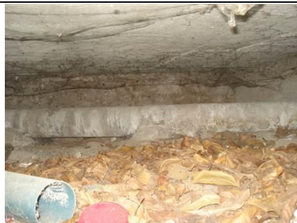
Photo n° PhA005 Localisation : Vide-sanitaires Ouvrage : Conduits de fluides (air, eau, autres fluides) Partie d'ouvrage : Conduits Description : Conduit horizontal amiante ciment Localisation sur croquis : P5
