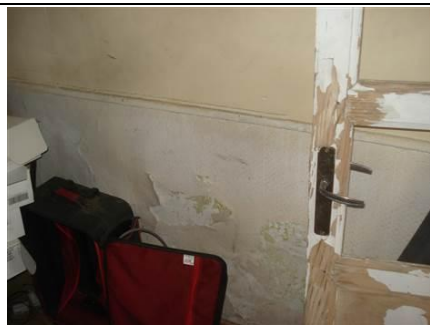
Photo n° PhA003 Localisation : Ancienne salle à manger Ouvrage : Murs, Cloisons "en dur" et Poteaux (périphériques et intérieurs) Partie d'ouvrage : Enduits projetés Description : Crépi rouleau - Mur bas Localisation sur croquis : P3
