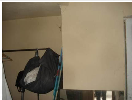
Photo n° PhA004 Localisation : Ancienne salle à manger Ouvrage : Murs, Cloisons "en dur" et Poteaux (périphériques et intérieurs) Partie d'ouvrage : Enduits projetés Description : Enduit beige - Mur Localisation sur croquis : P4
