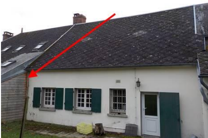
Photo n° PhA002 Localisation : Extérieur - Maison Ouvrage : Conduits en toiture et façade Partie d'ouvrage : Conduites en amiante-ciment Description : Conduite en amiante-ciment Localisation sur croquis : M002
