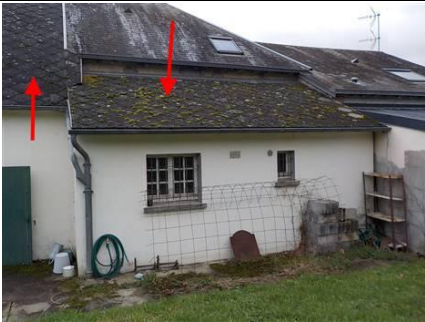
Photo n° PhA001 Localisation : Extérieur - Maison Ouvrage : Bardages et façades légères Partie d'ouvrage : Ardoises (fibres-ciment) Description : Ardoises (fibres-ciment) Localisation sur croquis : M001
