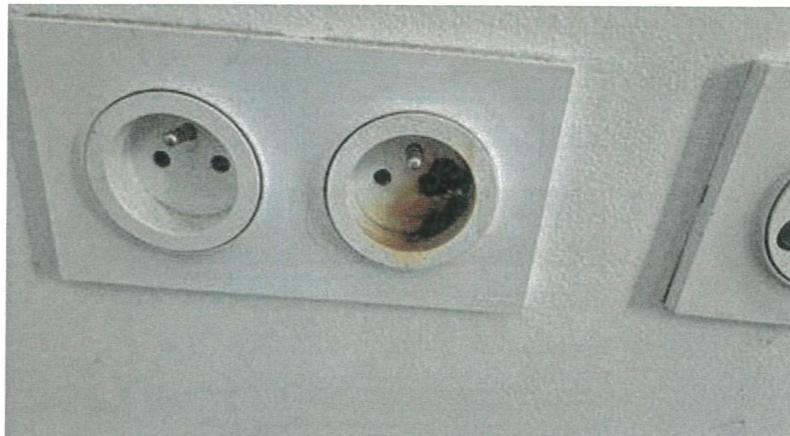
*Description :* Des CONDUCTEURS ou des APPAREILLAGES présentent des traces d'échauffement.
