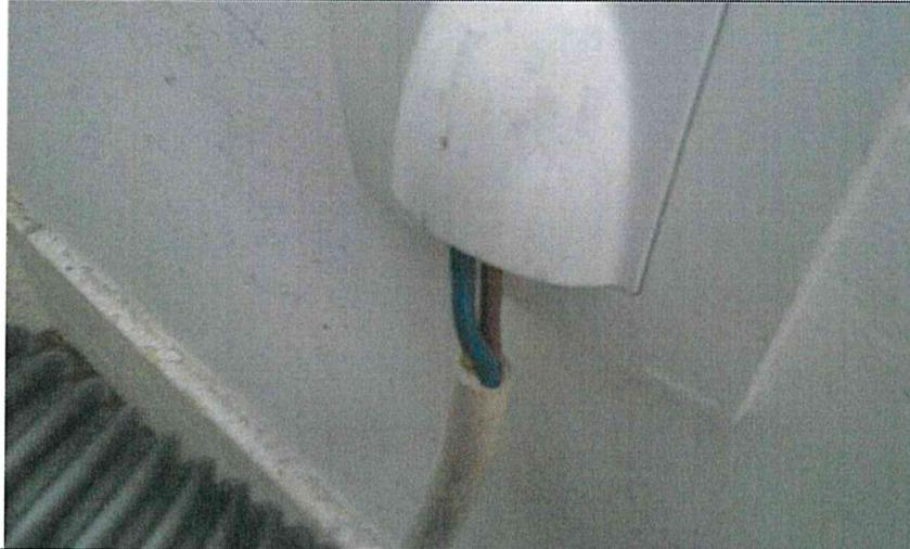
Description : Au moins un CONDUCTEUR isolé n'est pas placé sur toute sa longueur dans un conduit, une goulotte, une plinthe ou une huisserie, en matière isolante ou métallique, jusqu'à sa pénétration dans le MATERIEL ELECTRIQUE qu'il alimente.
