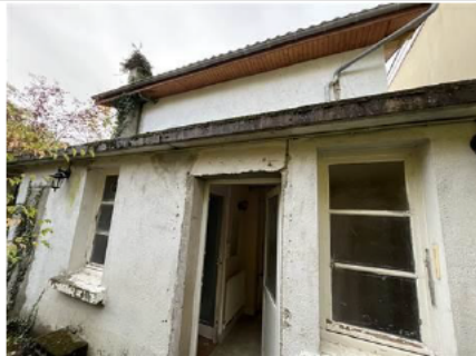
Photo PhDPE006 Ouvrage : Nord
