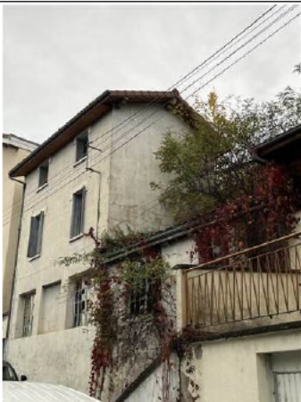
Photo PhDPE007 Ouvrage : Est
