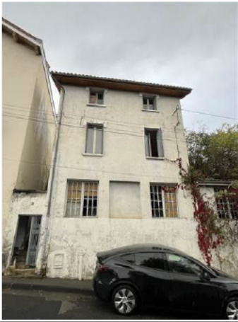
Photo PhDPE004 Ouvrage : Sud
