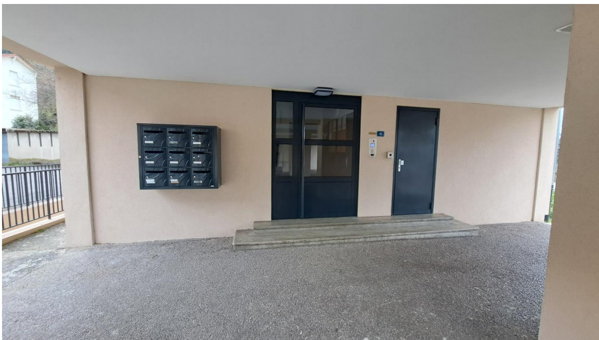
Vue de la porte d'entrée de l'immeuble
