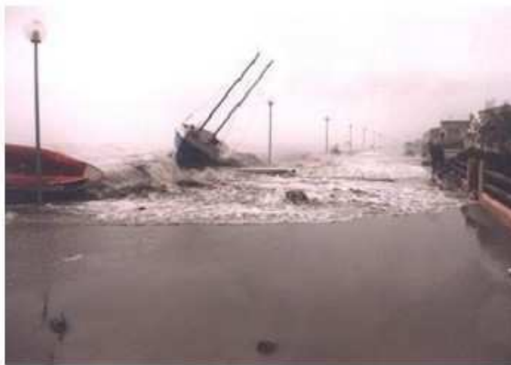
Effet du jet de rive (Narbonne plage – décembre 1997 – photo DRE)
