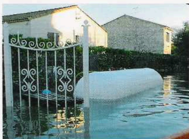
Cuve soulevée par l'eau.
